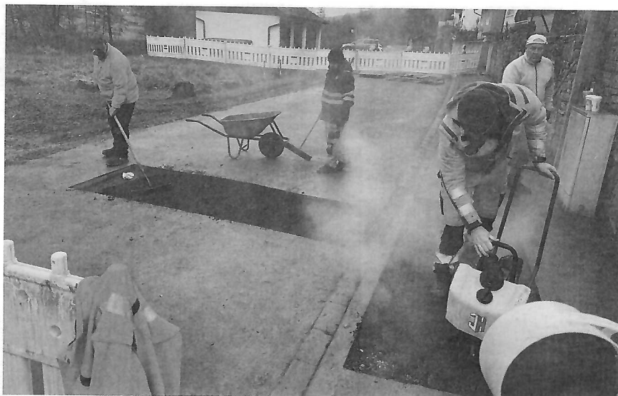
Auch „Klein-Aura“ bleibt nicht verschont. Auch hier sind die Straßenbauarbeiter tätig ...
